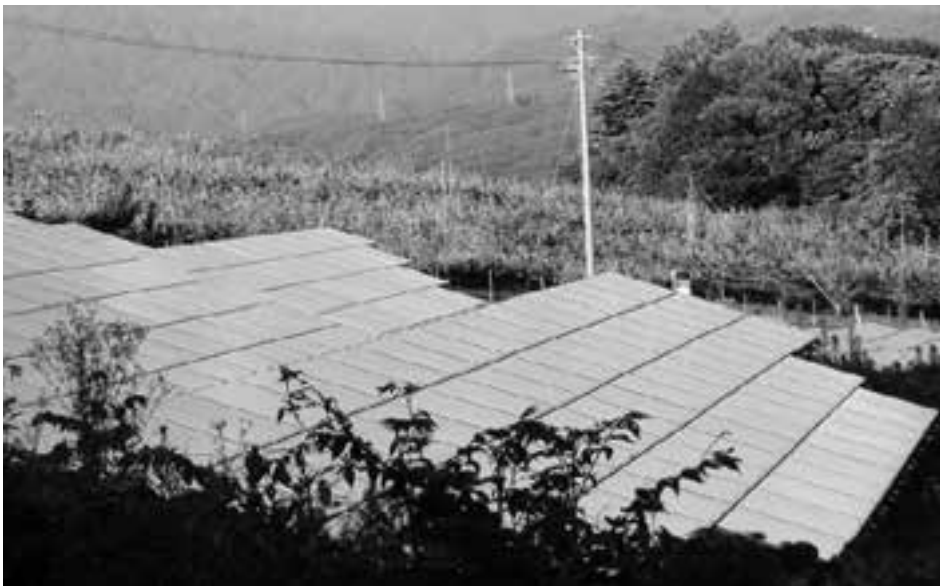
近隣町村の太陽光発電施設
