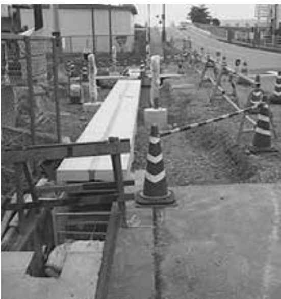
公共工事(道路)の現場
