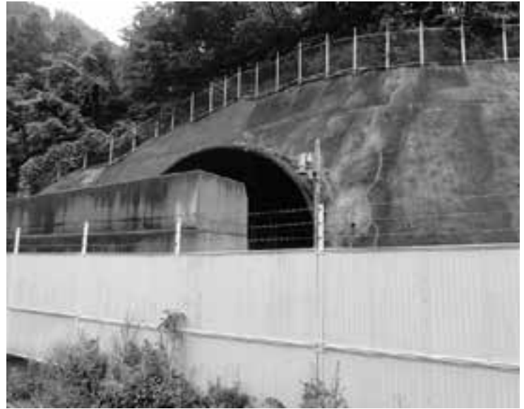
トンネル作業口：上野原市
