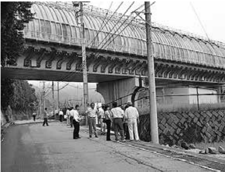
大平地区残土置場の上を水田利用している(道路右側)
