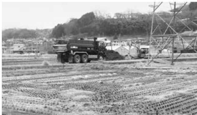
村の駅とよおか(仮称)の敷地整備が始まった
