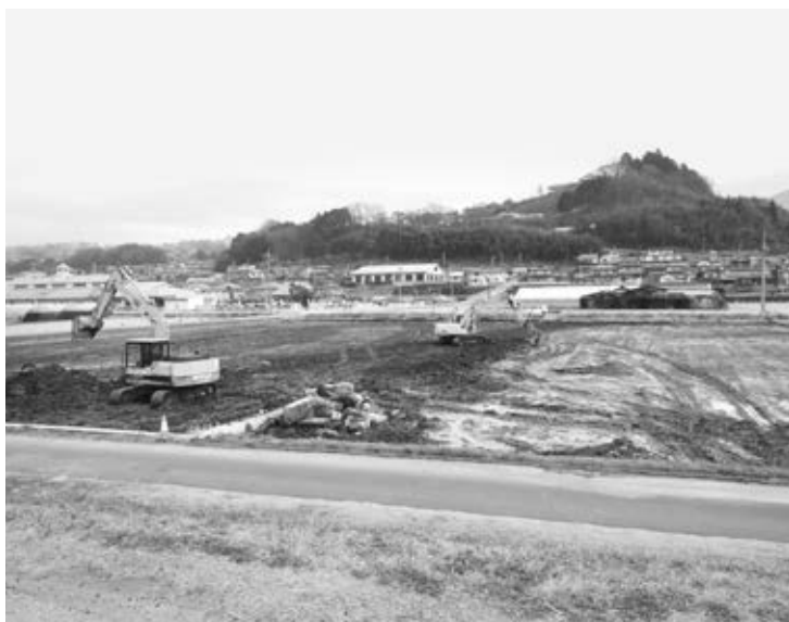
耕土搬出が進む村の駅建設地（林里）
