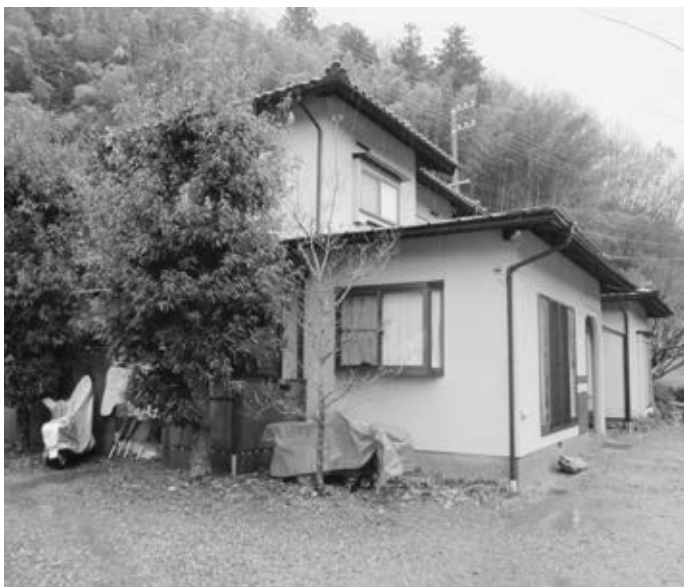
耐震化改修の補助を受け、壁面積を増やした木造住宅（小園）
