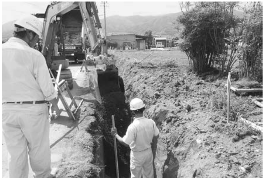
水道管布設替の様子
