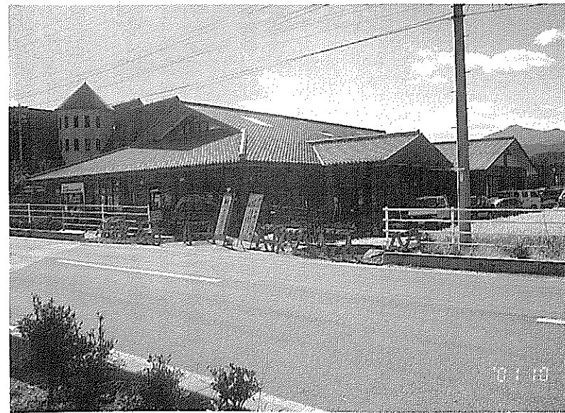
完成間近い介護予防施設「はつらつ」
