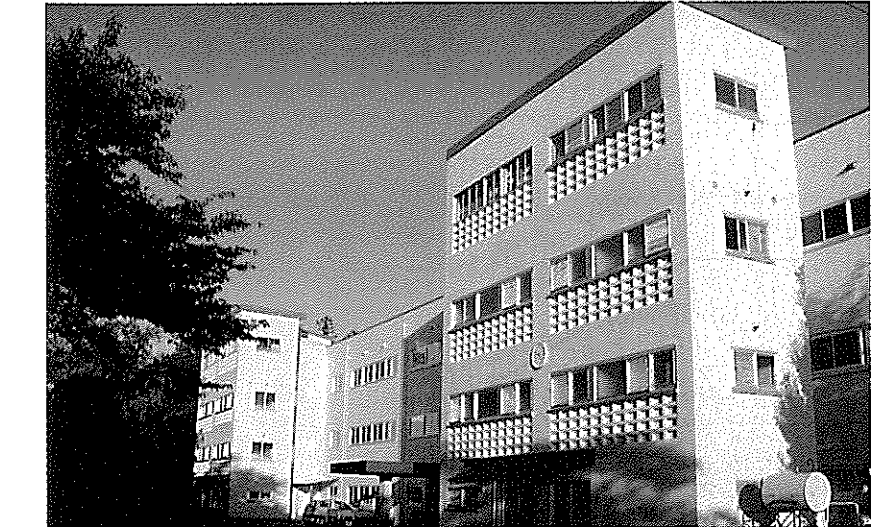
老朽化が進む中学校校舎
