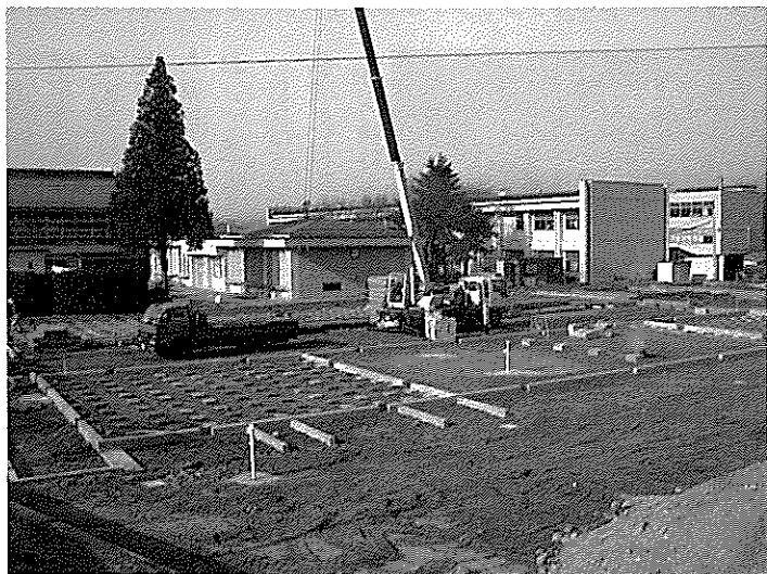
中学校仮設校舎建設現場
