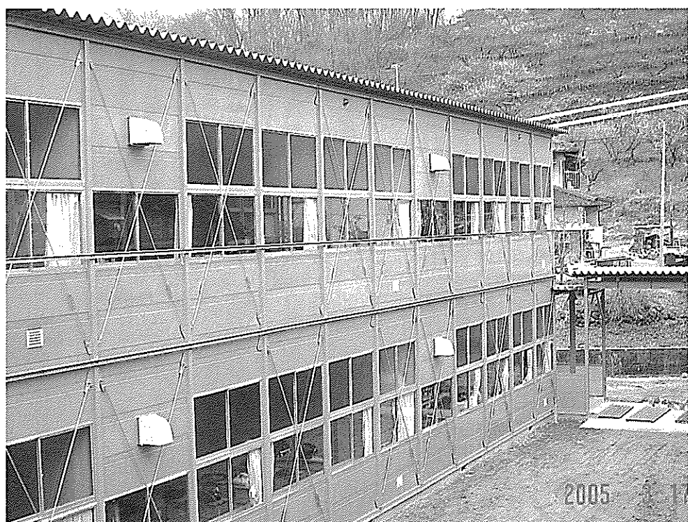
中学校仮設校舎
