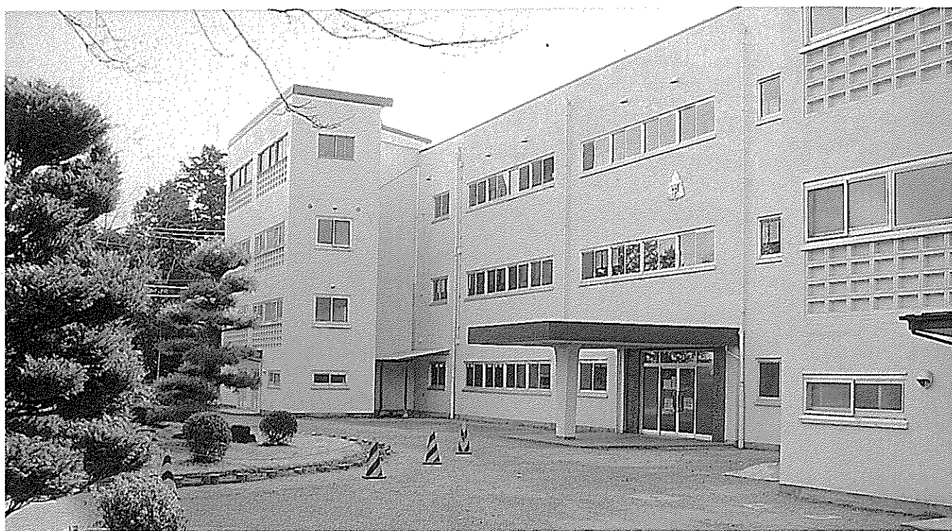
ありがとう47年間（解体前の中学校）
