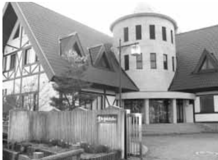
起債の償還が続く下水道施設
