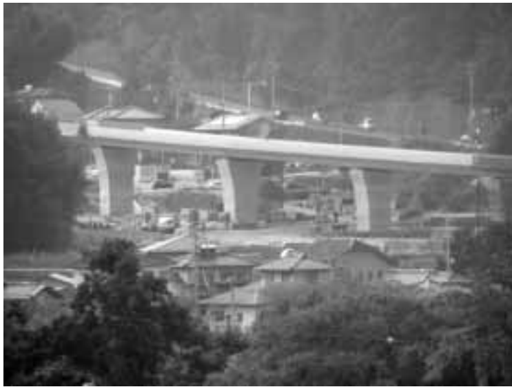
着々と工事進む三遠南信道（天竜峡付近）
