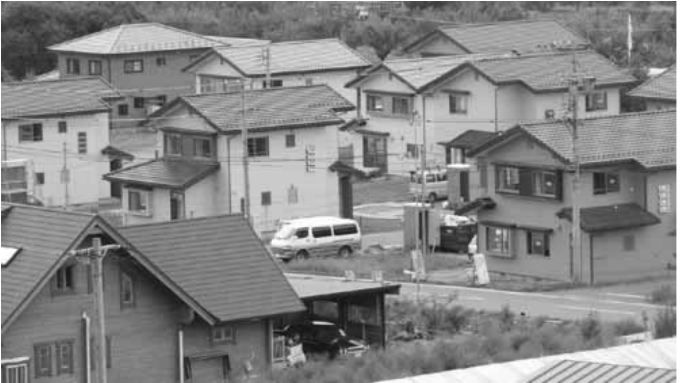
完成間近の山田賃貸住宅団地
