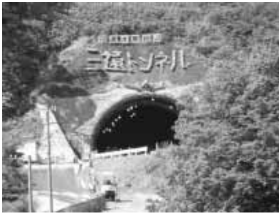
着々と進む三遠南信道工事
