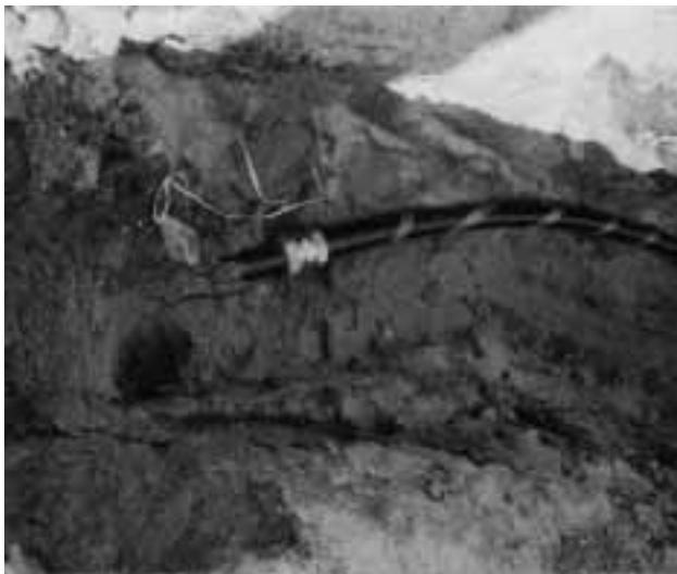
水道管敷設工事
