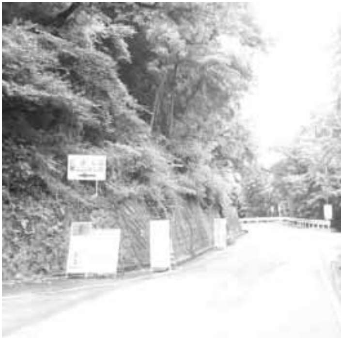
着工となった佐原線(中学校入口)
