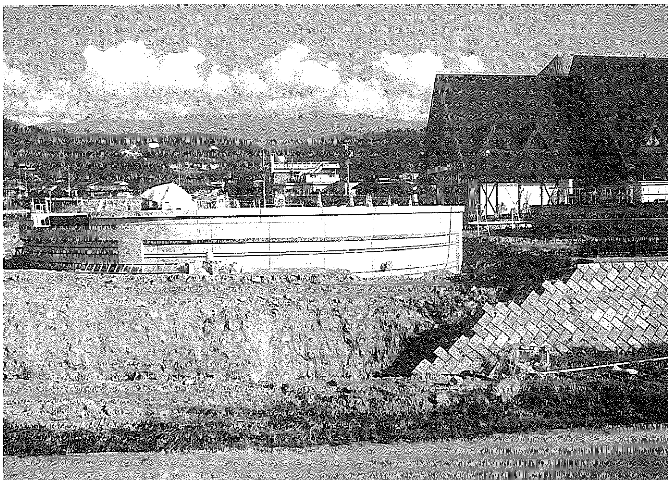
建設中の林里下水処理槽 (第3基)
