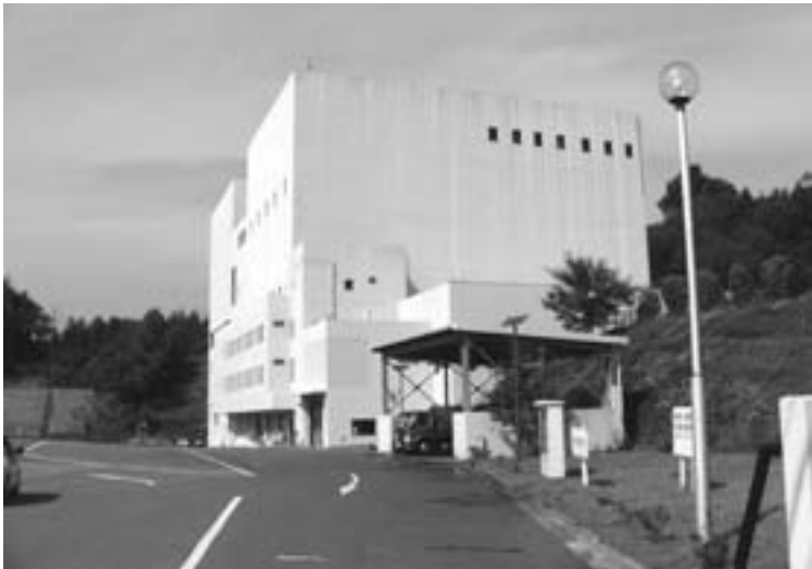
7年を経過した桐林クリーンセンター
