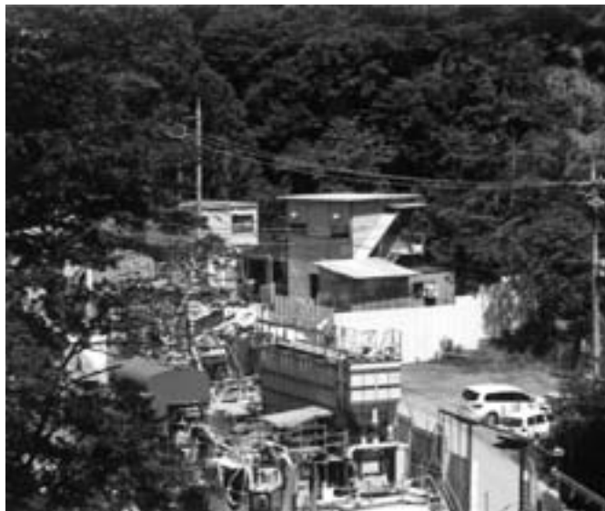
山梨県早川町ボーリング工事現場
