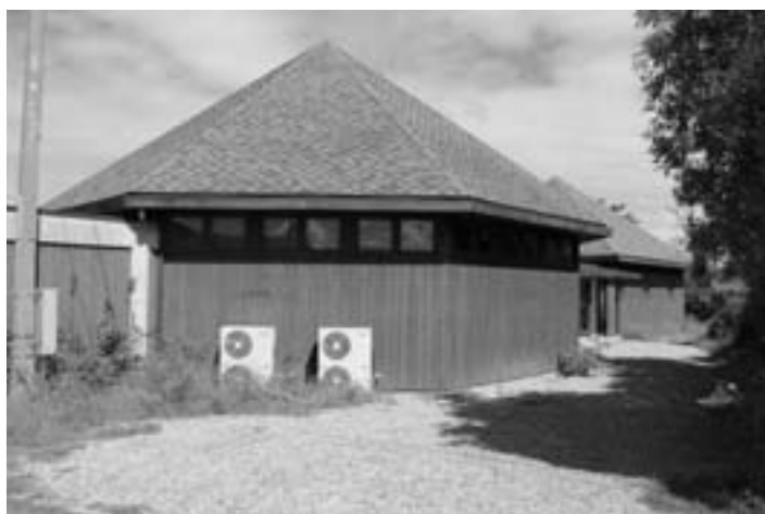
福祉センターの別館となった旧東洋大セミナー棟
