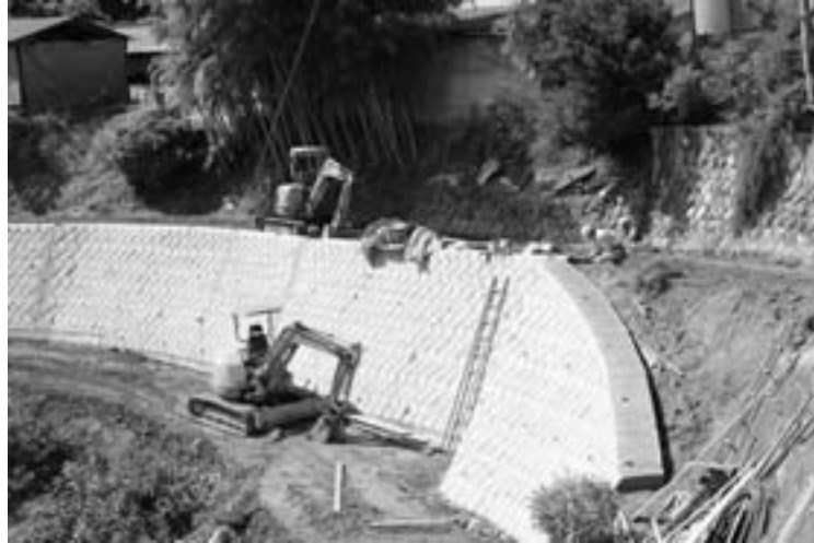
村発注工事現場
