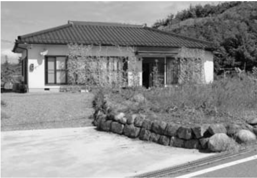
荒廃空き家整備事業で改装なった住宅
