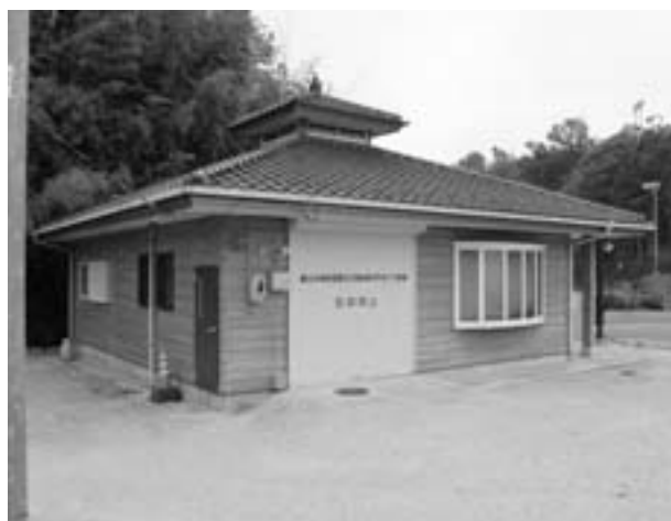
消防団詰所となった旧テニスコート管理棟
