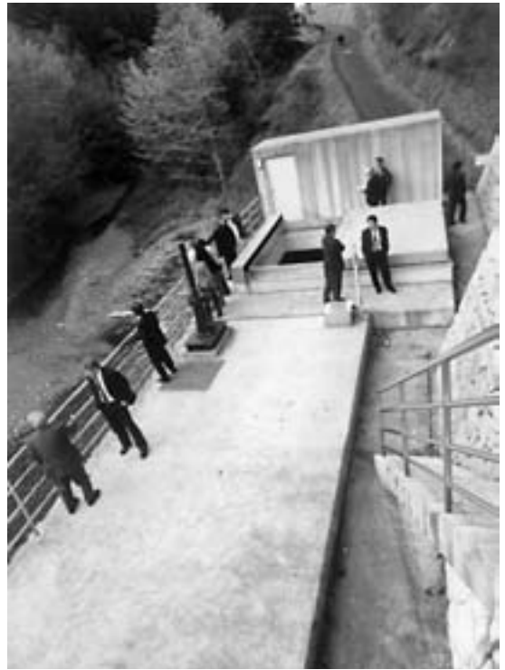
梼原町 小水力発電所
