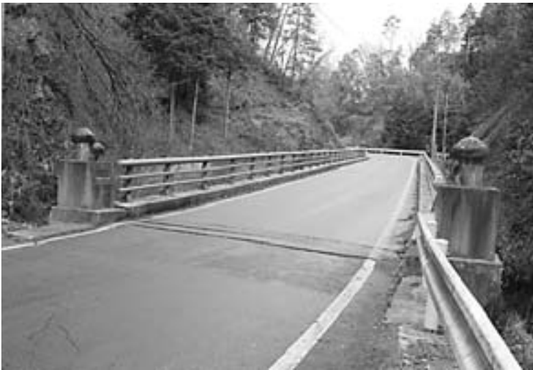
塩カル腐食で改修される巻ヶ城橋
