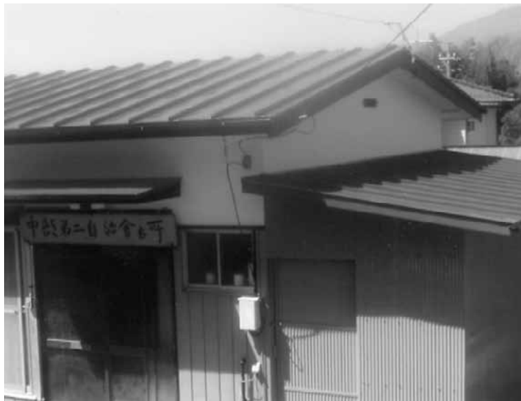
屋根と外壁をリフォームしてきれいになった中部二会所
