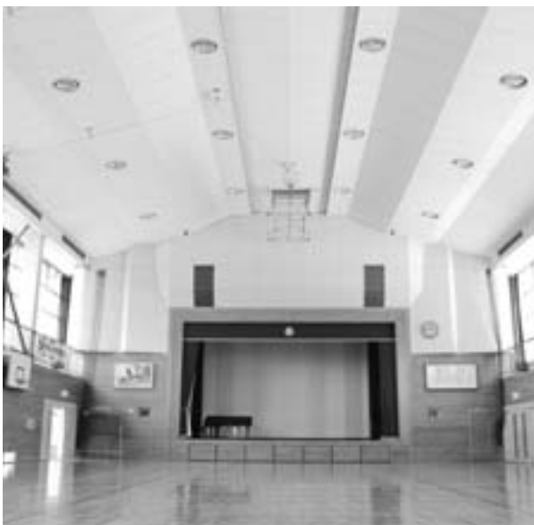
北小学校体育館の天井
