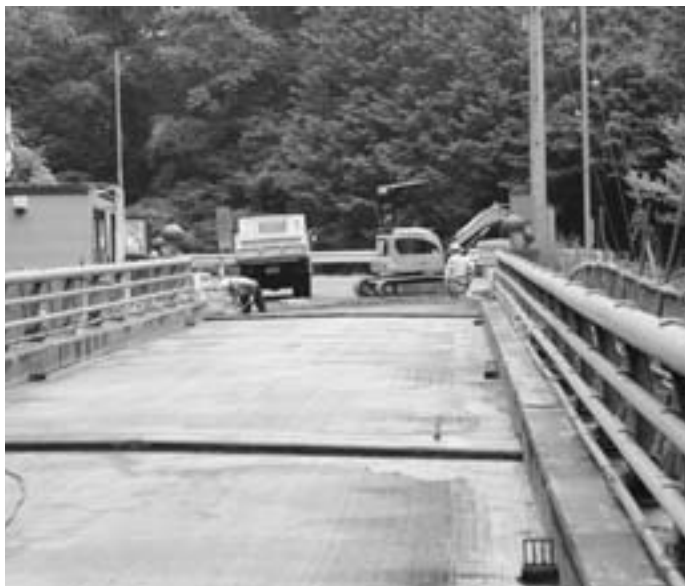
改修が進む巻ヶ城橋
