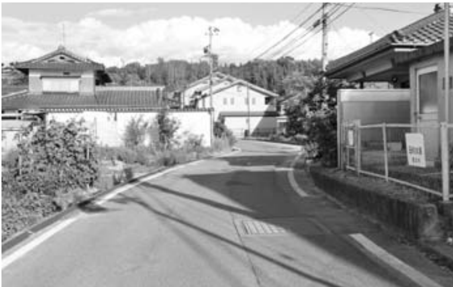
見通しの悪い森谷線改良予定箇所
