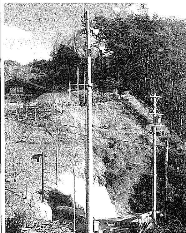
壬生沢東地籍のパンザマスト
