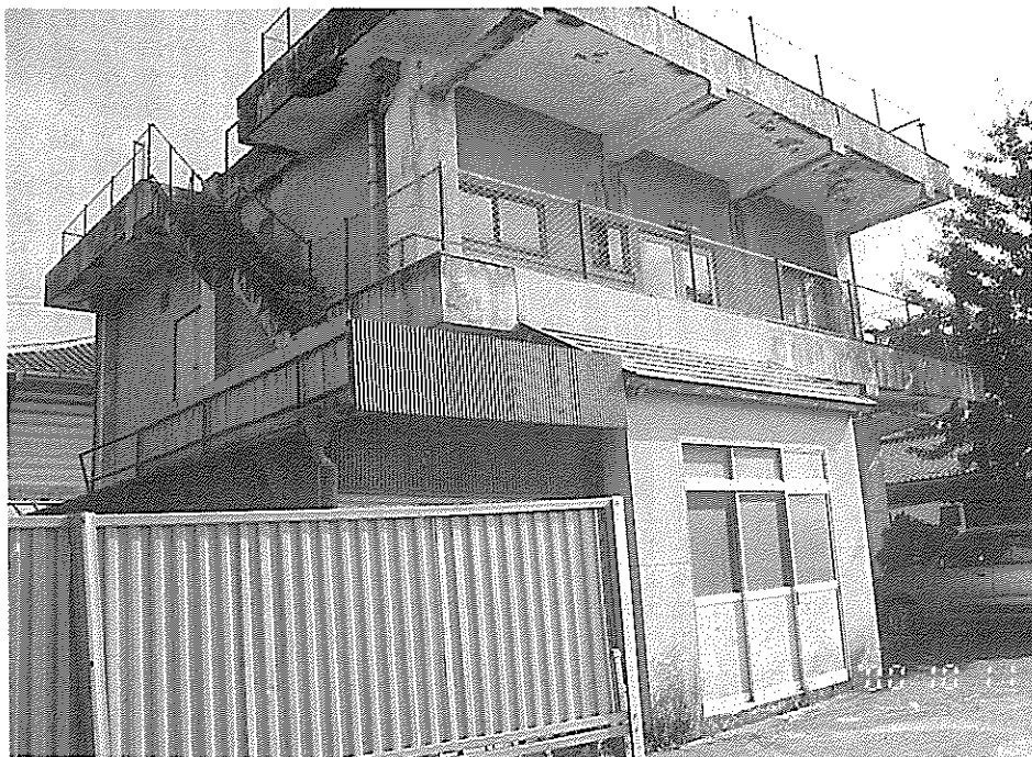
一時保管庫となる旧有線事務所
