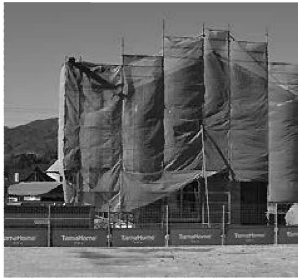
建築が進む民間開発の住宅団地
