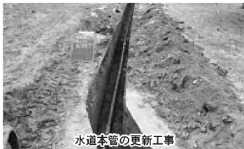
水道本管の更新工事
