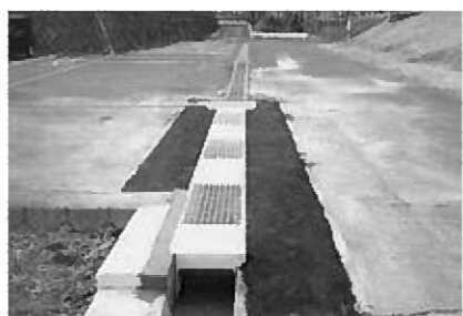
用排水路の改修
