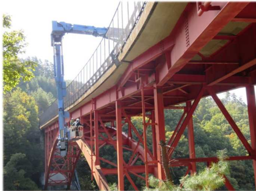
橋梁の補修(虻川大橋)
