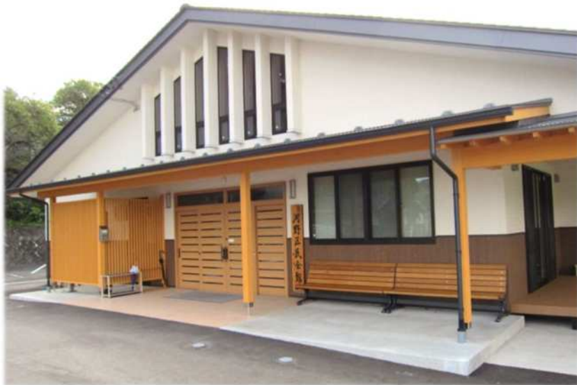
コミュニティの拠点である区民会館(河野区民会館)
