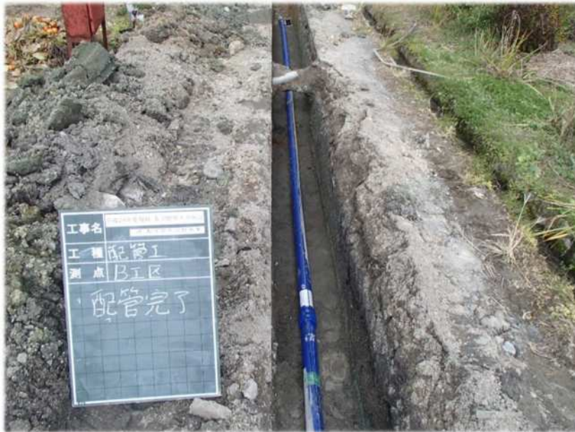
水道管更新工事
