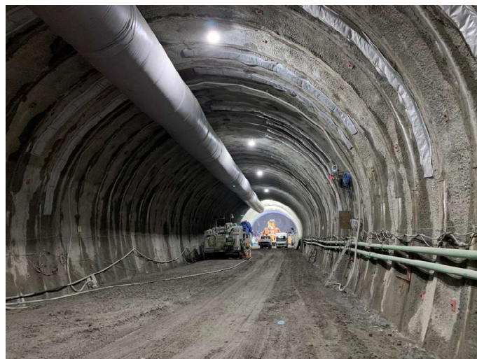
斜坑トンネル坑内
