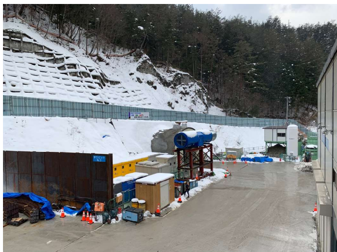
坂島非常口ヤード
