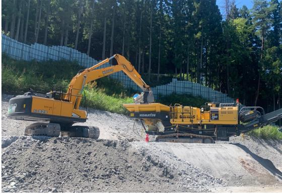
トンネル掘削で発生したスリ(岩塊等)を細かく砕き砕石を作成します。
