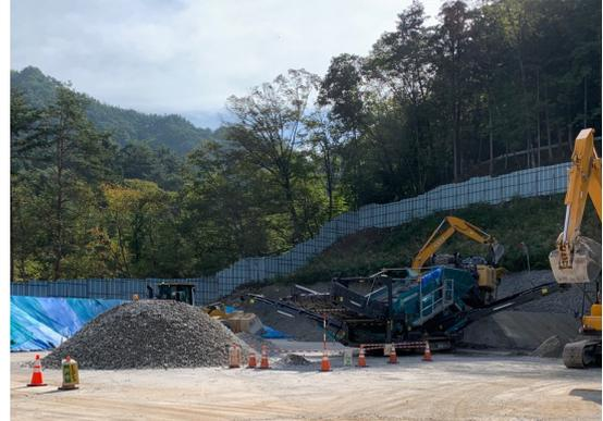
作成された砕石はフィルター材として地下排水管の周囲に使用します。
