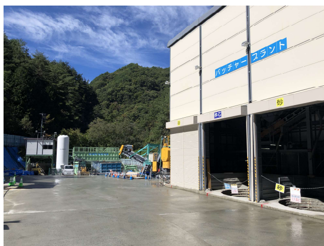
非常口ヤード
