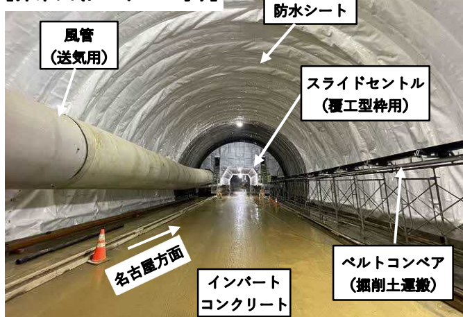
【非常口(トンネル工事)】
