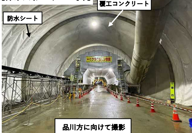
【非常口(トンネル工事)】
