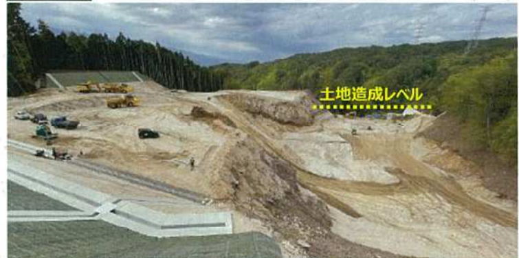
写真⑤ 変電所ヤード 切土・盛土状況
