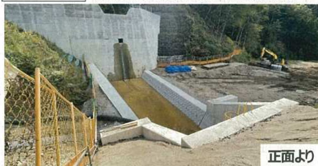
写真①-2 沈砂調整池堰堤 下流水路 構築完了
