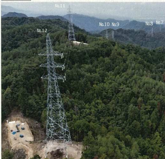
写真① 小波川線No.4~No.12 架線工事 (完了)
