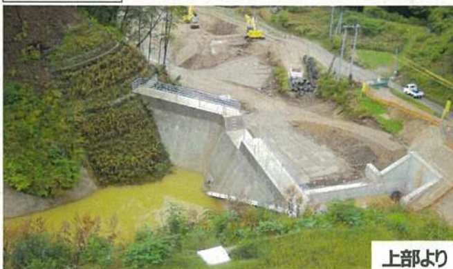
写真①-2 沈砂調整池堰堤 下流水路 構築完了
