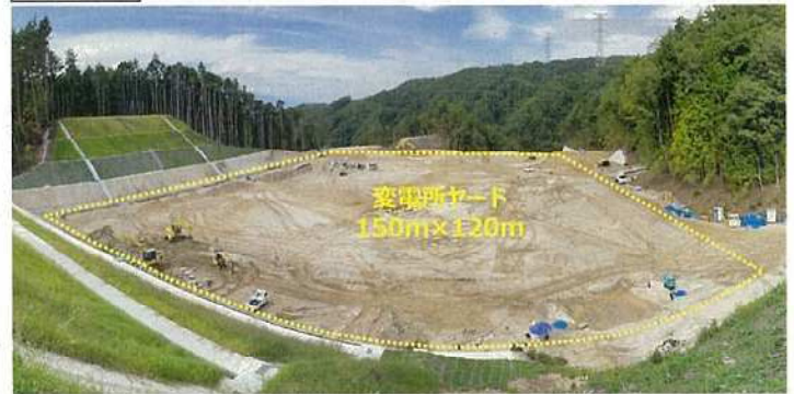
写真⑤ 変電所ヤード 造成状況
