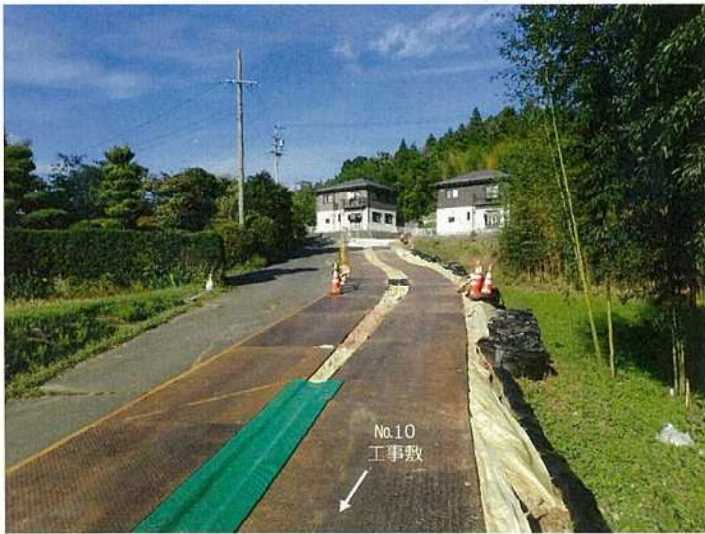
写真③ 豊丘線No.10 搬入路拡幅 (完了)
