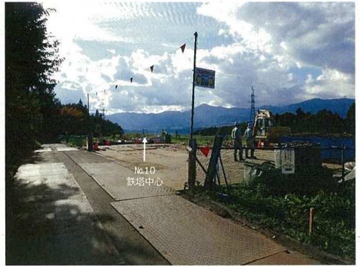
豊丘線No.10 基礎工事中
