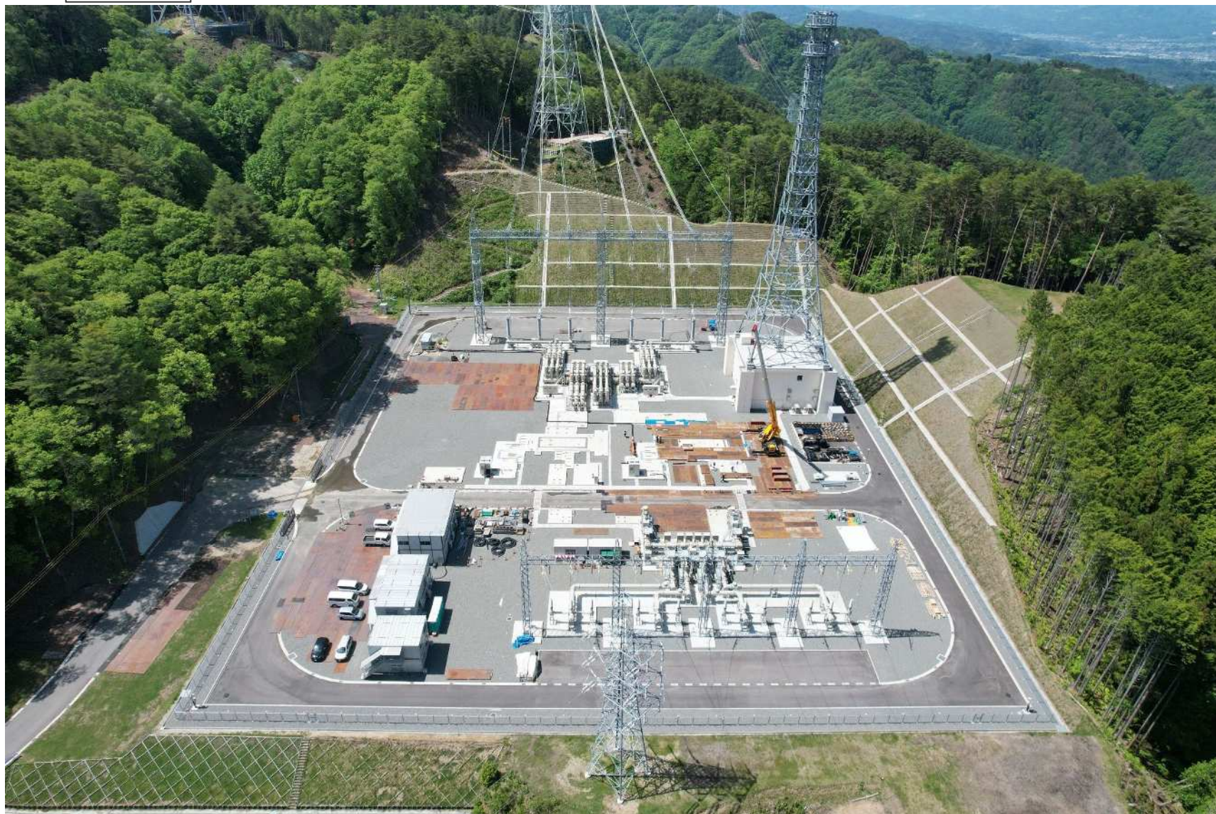
写真③ 変電所工事状況（上空より）
