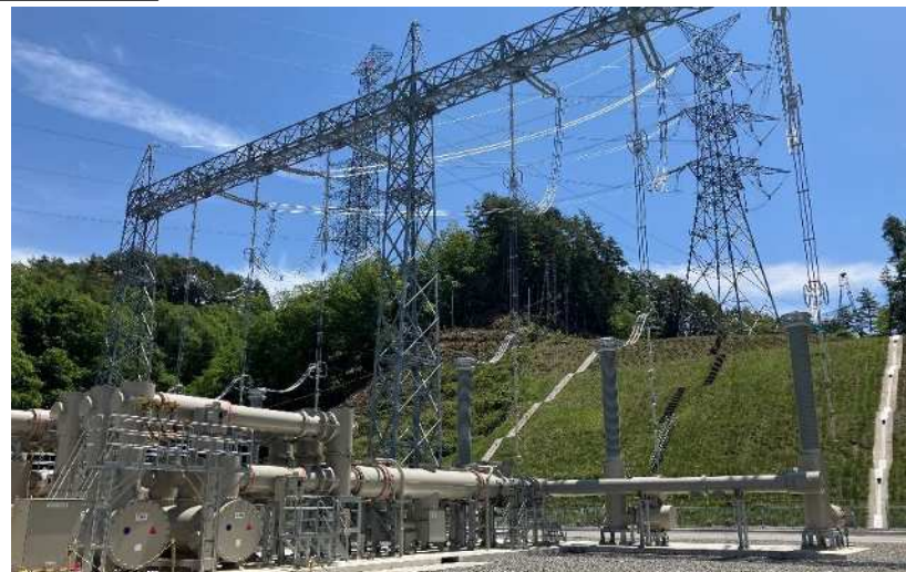
写真② 変電所154kV送電線引出口状況
